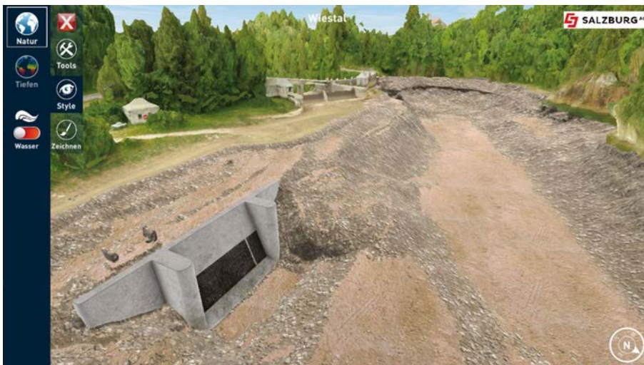
Bild 2. Digitaler Zwilling KW Wiestal mit entleertem Speicher. 8
